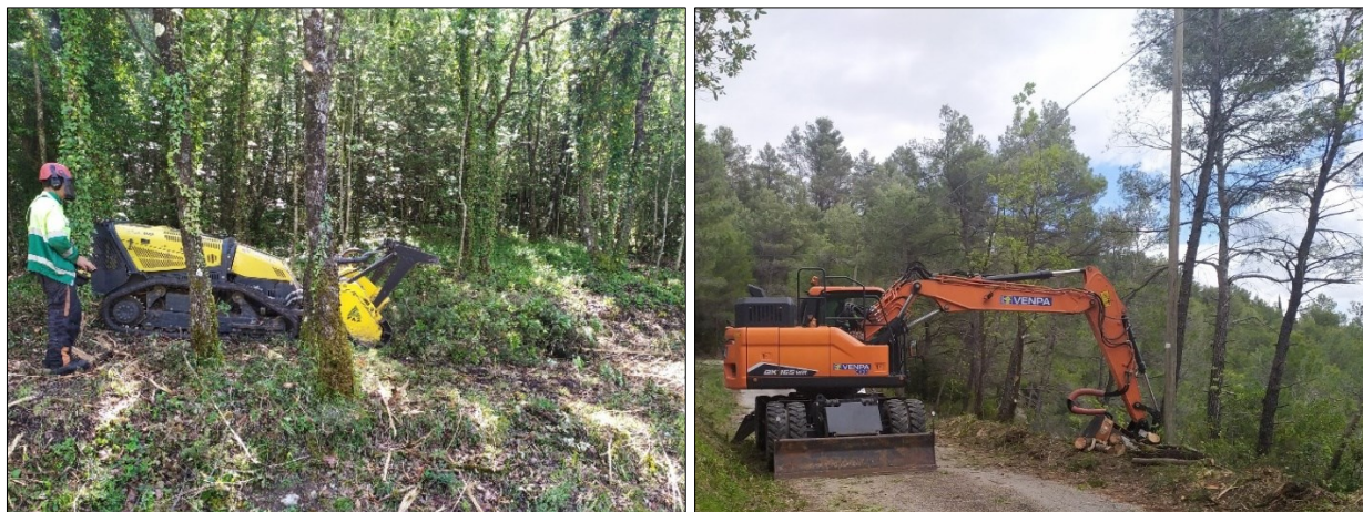
Foto 10 – Intervento PSR 8.3 loc. Castagnacupa - Spoleto
